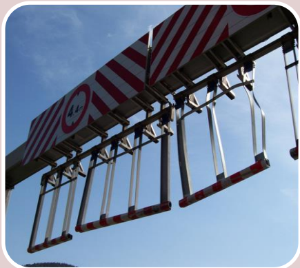
Des fléaux régulièrement détériorés
