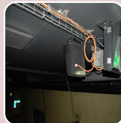
Feu d'affectation de voie
