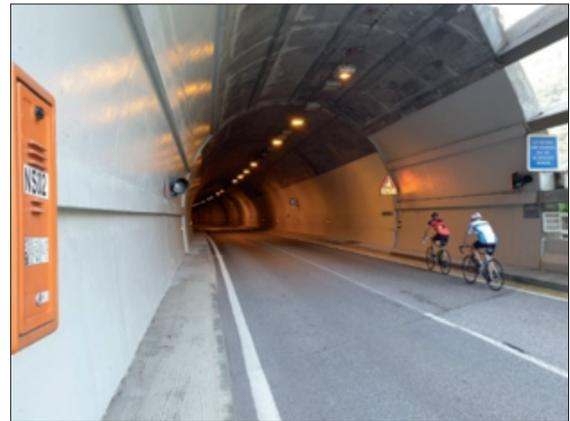
Aménagement d'une bande cyclable dans le sens montant au tunnel des Grands Goulets
