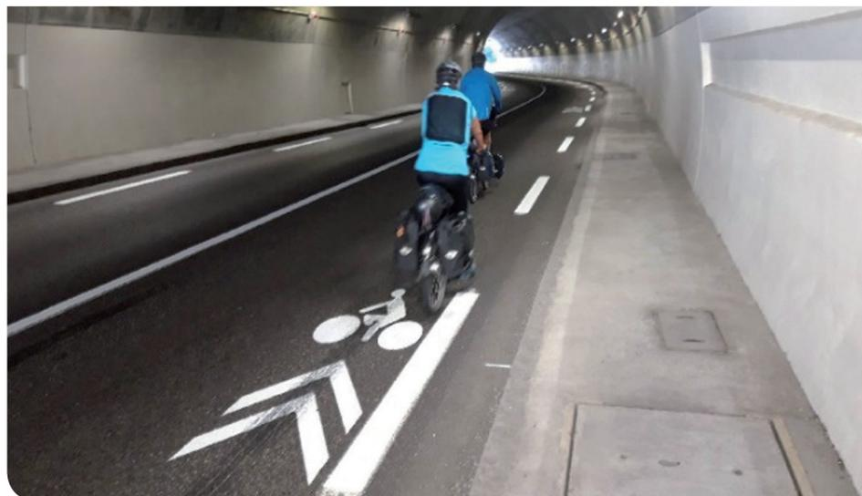
Marquage de positionnement des cycles en tunnel
