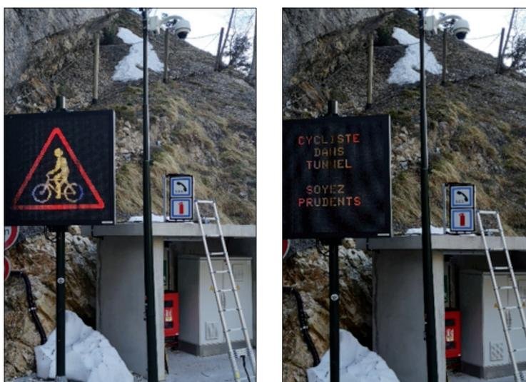
Système de détection par caméra thermique et d'alerte de présence cycliste au tunnel des Écouges
