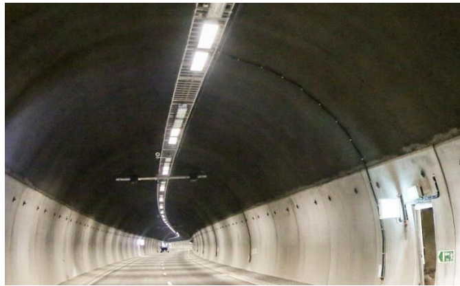
Classe D, E et F: Type 2 PE+BPA en voûte
