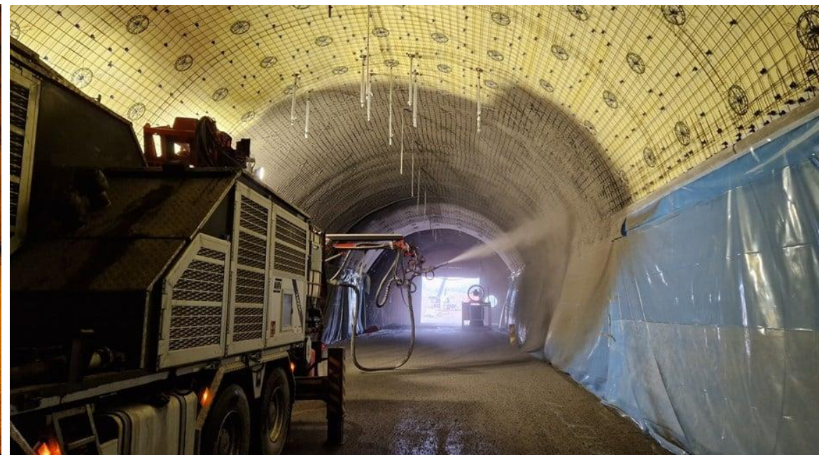
Béton projeté armé en voûte - E16 Bukkesteinshøgdtunnelen Foto: Statens vegvesen
