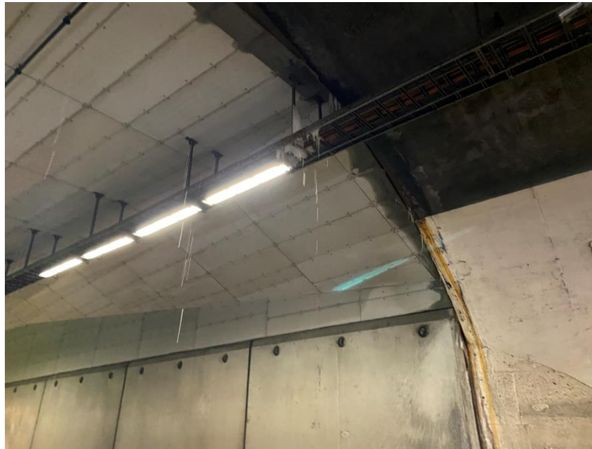
Jointure entre tunnel rocheux et tranchée couverte
