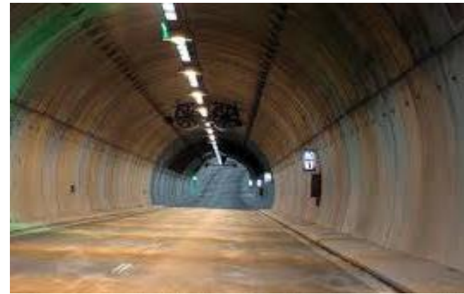
Classe D, E et F: Type 3 Voussoirs béton en voûte
