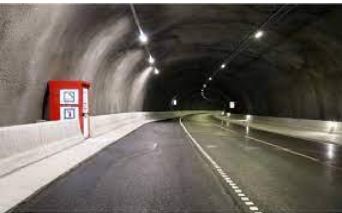
Classe B et C: Type 1 PE+BPA+glissière beton
