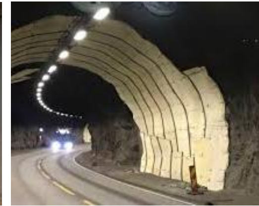
Type 4: PE sans protection au feu
