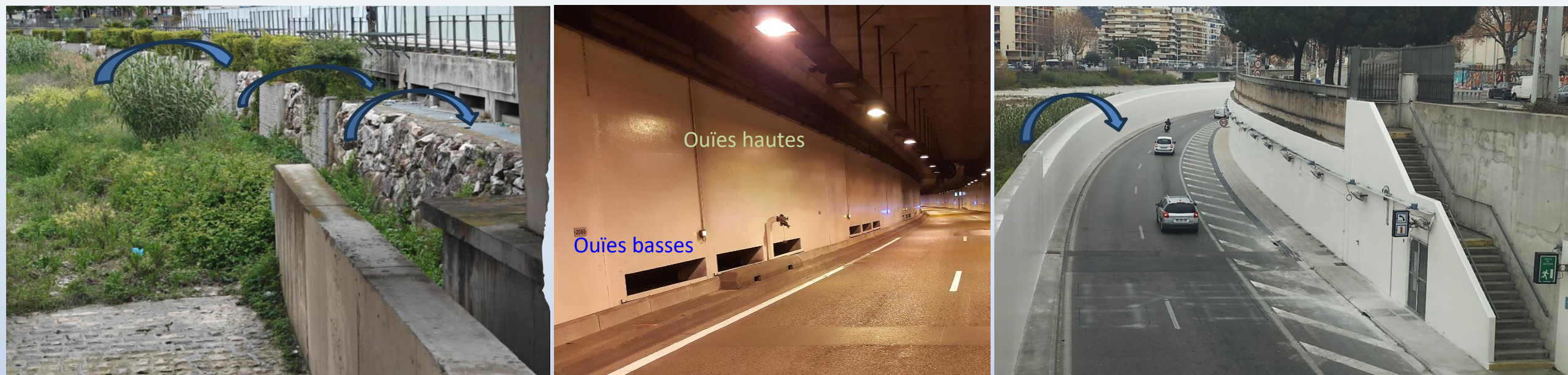
Vue des déversoirs du Paillon dans le tunnel
