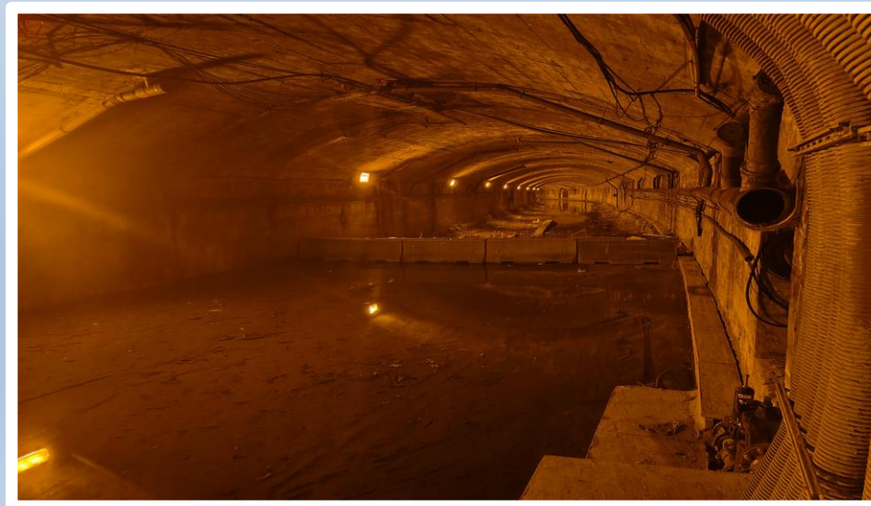
Vue des déversoirs du Paillon dans le tunnel
