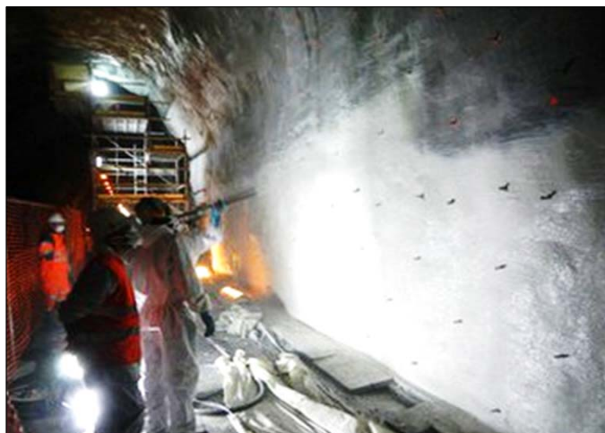
Projection de l'étanchéité
