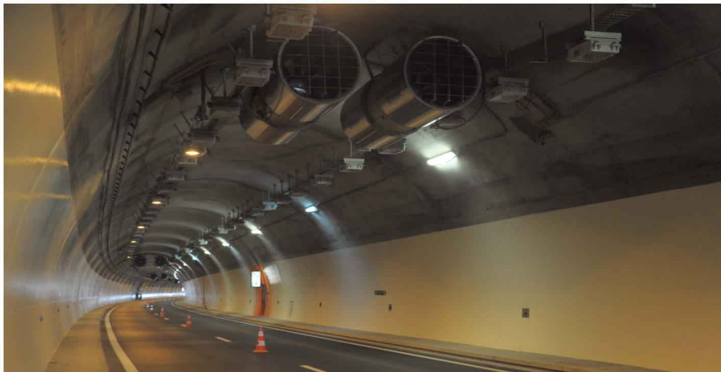
Tunnels de VDLAY (42), Bussière et Chabasset (69)
