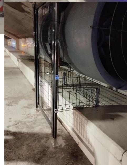
Dépose, rénovation entière et fixation sur zones renforcées avec élingues de retenue des 34 anciens accélérateurs
