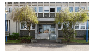
Entrée du bâtiment
