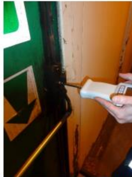
Figure 56 : Mesure de la force nécessaire pour l'ouverture de la porte piéton
