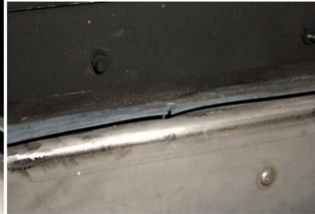
Figure 38 : joint trappe légèrement coupé
