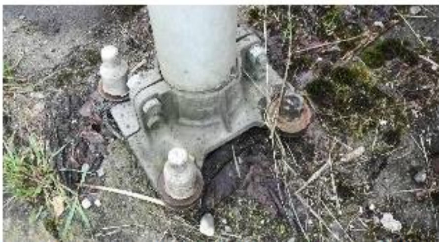
Figure 100 : Boulonnerie de fixation du panneau lumineux "Ecoutez 107.7"
