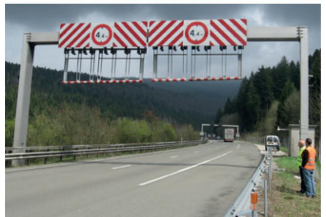
**Les barrières de fermeture** sont en général déclenchées à distance de façon automatique. Ces barrières sont obligatoires pour les tunnels de plus de 800m et sont situées environ 50m en amont de ceux-ci.
